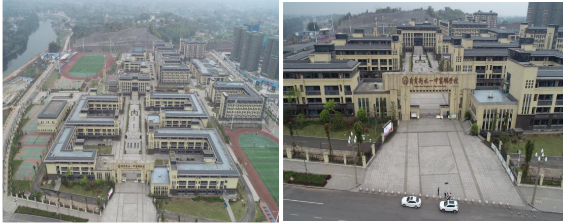
学校建设区现状情况
