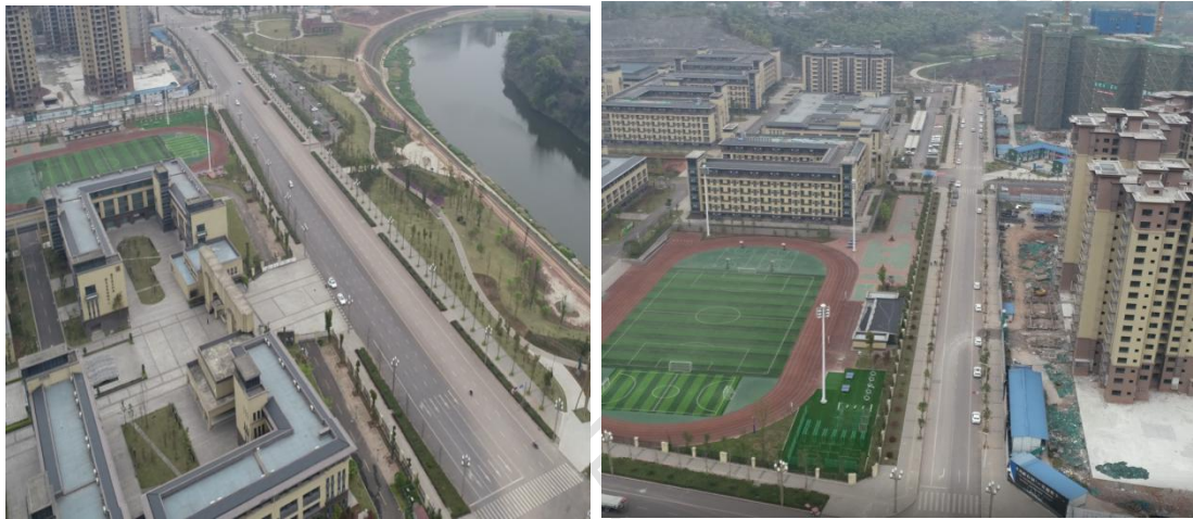
道路建设区现状情况
